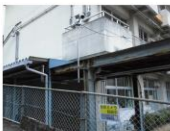
設置箇所（体育館と校舎の間）
